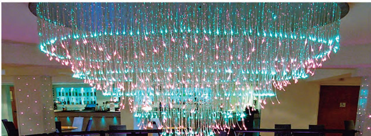
LÁMPARA COLGANTE FORMADA POR BASE DISTRIBUIDORA Y FILAMENTOS DE FIBRA ÓPTICA
