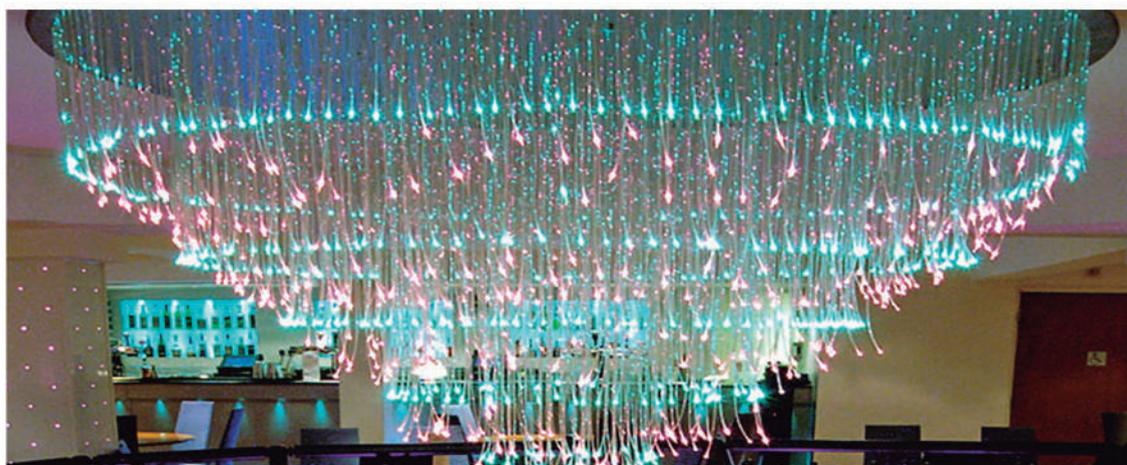
LÁMPARA COLGANTE FORMADA POR BASE DISTRIBUIDORA Y FILAMENTOS DE FIBRA ÓPTICA
